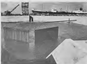
DOS PIER a worde traha pa acomoda 50,000 tanquero di peso morto den parti poboa y pa zuid di haaf, ariba. Awa di drenaje, abao, ta worde pasa pa un proceso special di purificacion.
